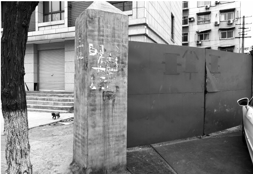
未拆除的大门
