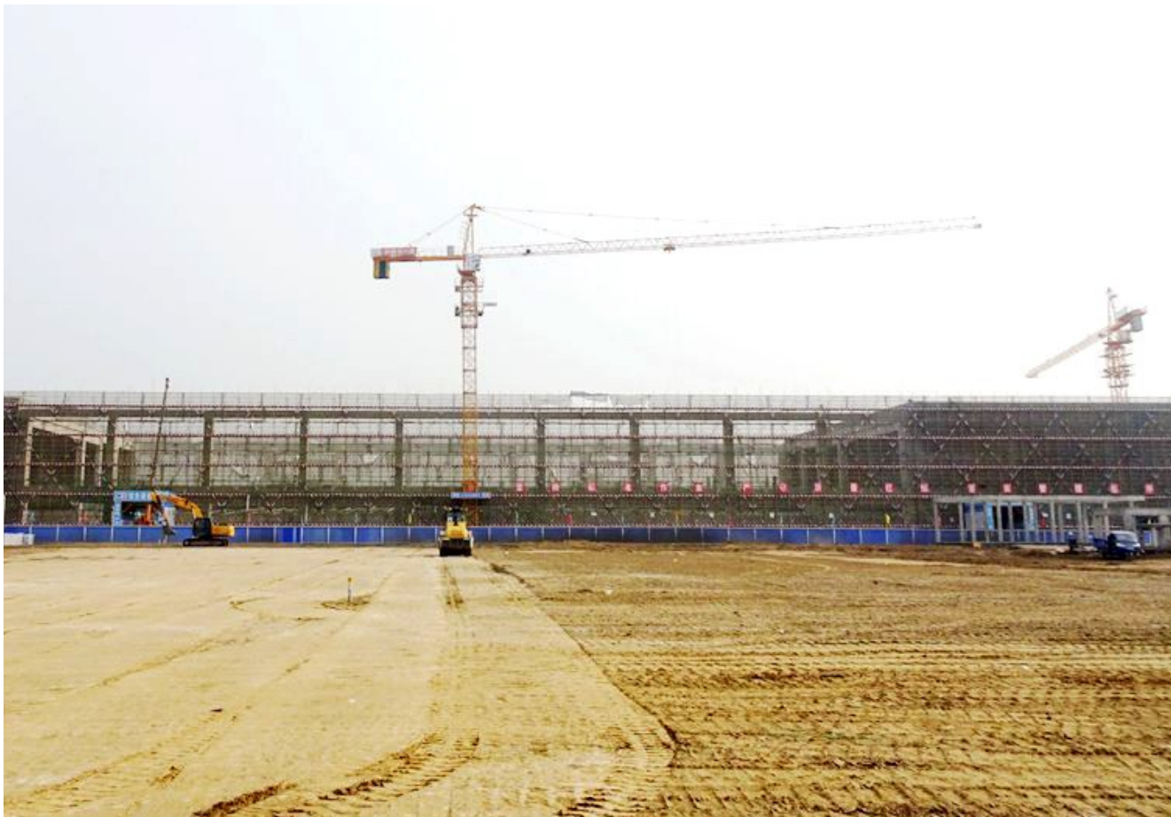
正在建设的郑合高铁许昌北站 资料图片由记者吕正子提供
