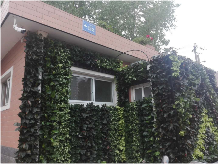
万丰路北段的一座公厕完成立体绿化,成为我市首座立体绿化公厕。
