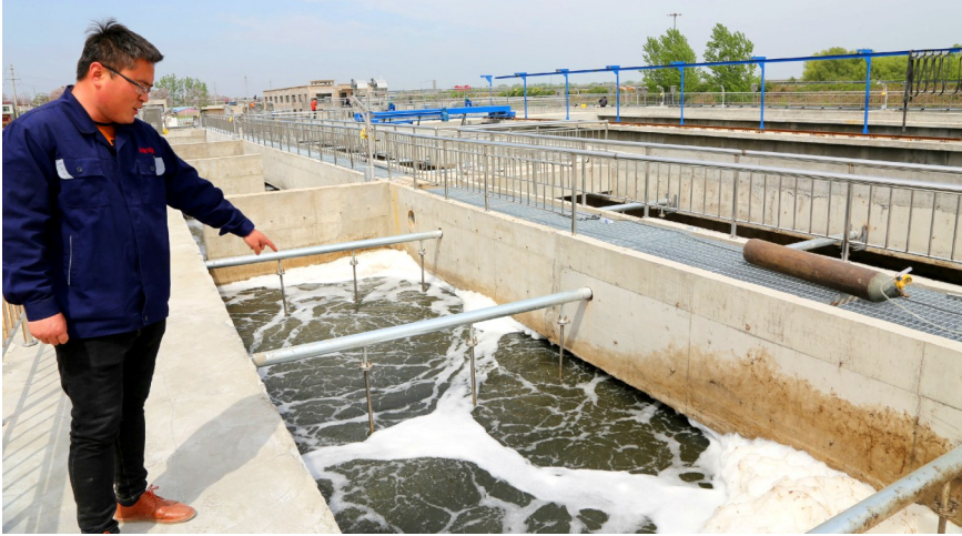
灵井污水处理厂内的生化池正在培养活性菌。记者 郝晋 摄
