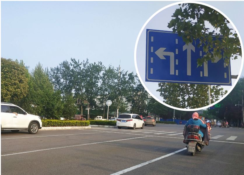
五一路与八一路交会处北侧设有道路导向牌,路面没有导向箭头。
