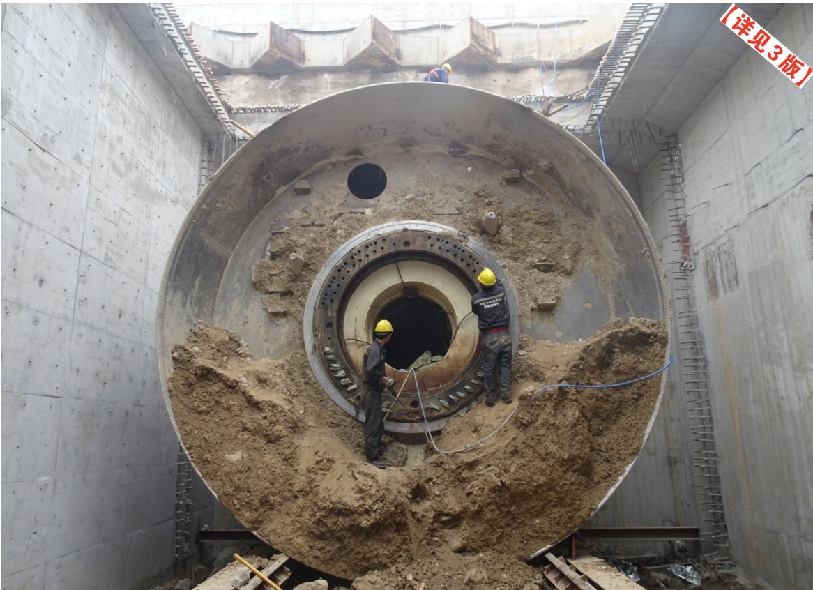
5月5日,工人正在清理“许都一号”盾构机的前盾。记者 吕正子 摄
