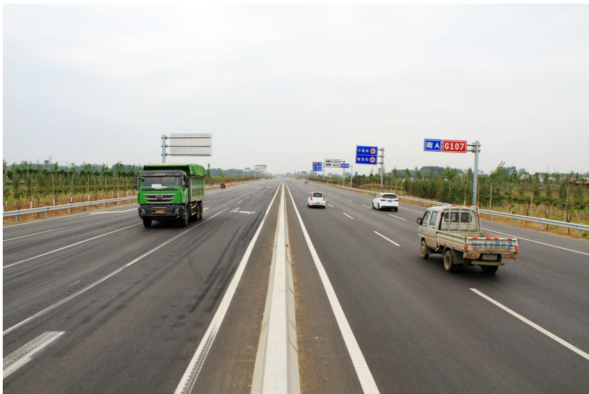
新 107 国道建成段双向六车道,平坦宽阔。
