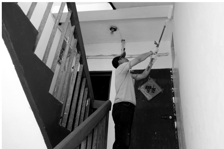
施工人员在粉刷墙面。
