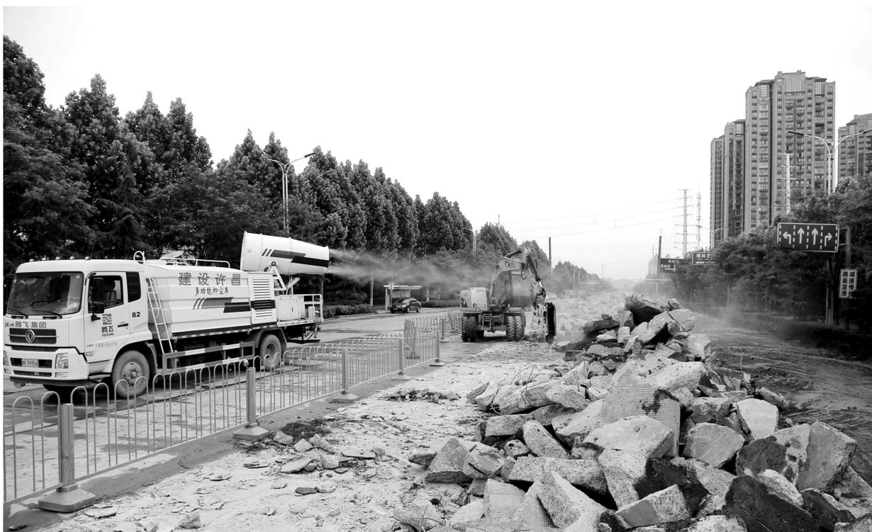
文峰北路(永昌路—彭花公路)提升改造工程施工现场,东半幅正在进行混凝土路面破碎清运。
