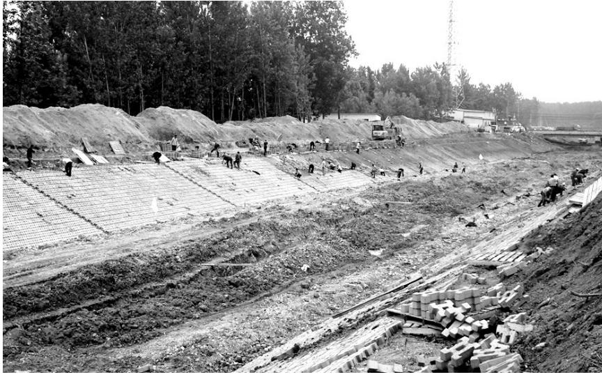
庞庄社区附近渠段,工人正在铺连锁砖。记者 吕正子 摄
