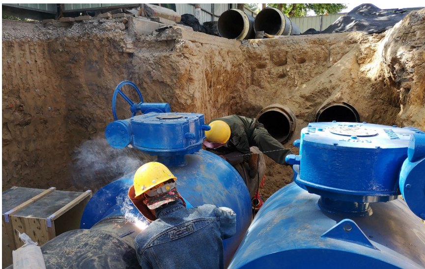
两名电焊工正在作业井内加紧施工。
