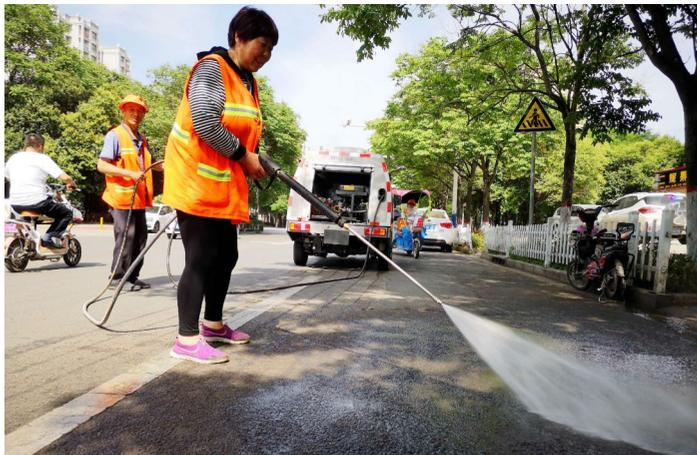
损伤车漆和污染路面的“元凶”就是树木上分泌的树胶和蚜虫的排泄物。环卫工人仅靠扫把无法清除树胶。洗扫车集扫路车与高压清洗车的功能于一体,在清扫路面的同时,可对路面进行
