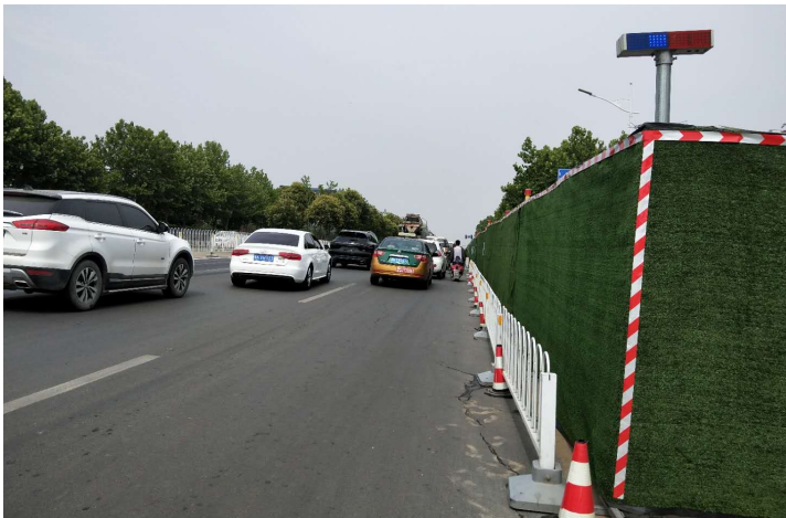
天宝路正在施工,骑行的市民在快车道上和机动车抢道,存在安全隐患。
