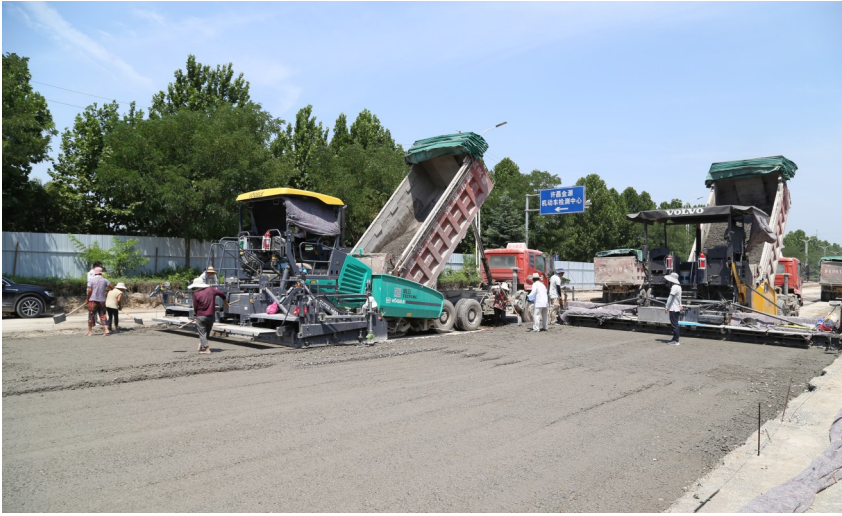
两台摊铺机前后相错约10米进行梯队作业,工人在后面不停地用铁锹平整碎石。
