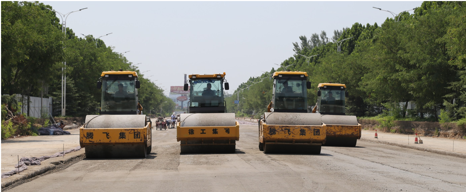
文峰路与昌盛路交叉口南约200米,数台压路机同时作业。
