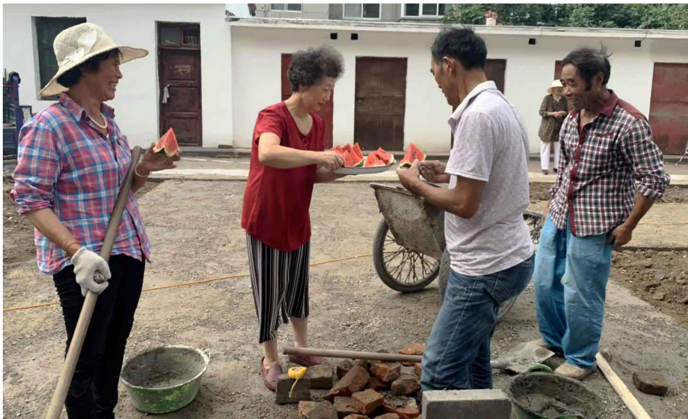
居民给施工人员送西瓜。
