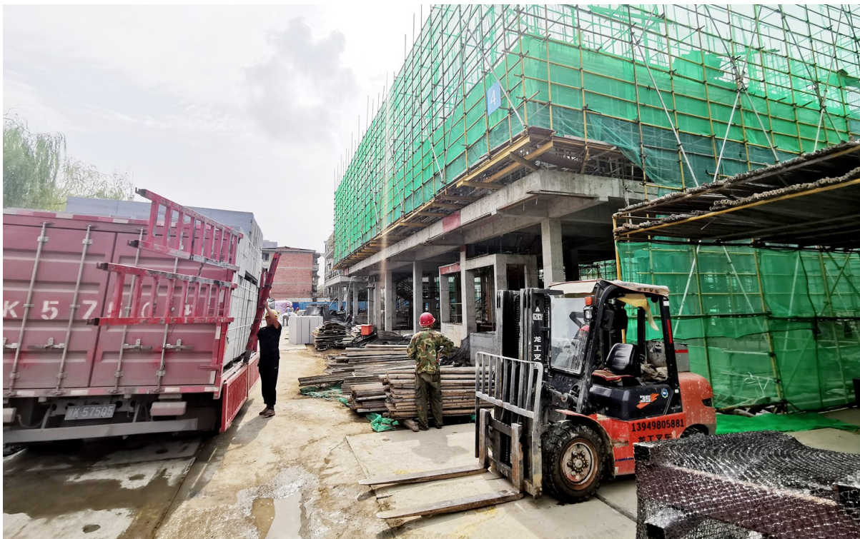
曹魏古城北城门施工正酣。记者 陈晨 摄
