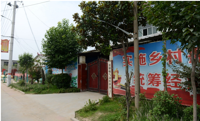
河南泓旭电气有限公司建设的扶贫车间 许昌报业全媒体记者 牛志勇 摄
