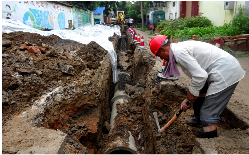
平安巷提升改造工程施工现场 记者 吕正子 摄
