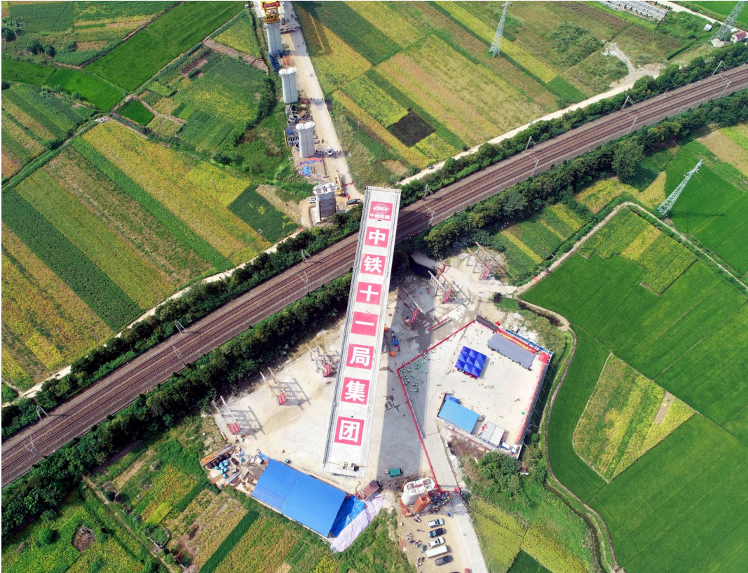
安九高铁长江特大桥跨京九铁路段成功转体
