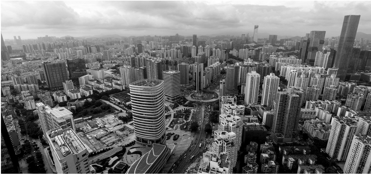
上图为位于深圳南头半岛上的南油开发区，下图为2018年6月20日拍摄的原南油开发区。新华社发
