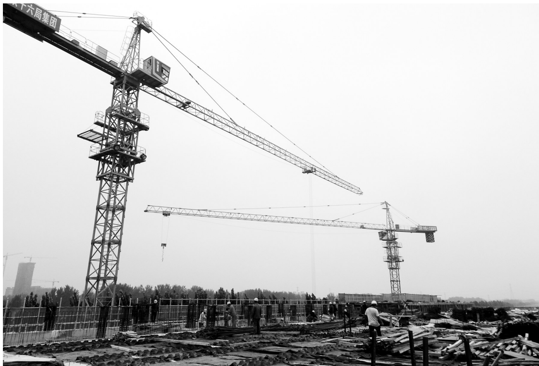
正在建设的郑许市域铁路农大路站站台层
