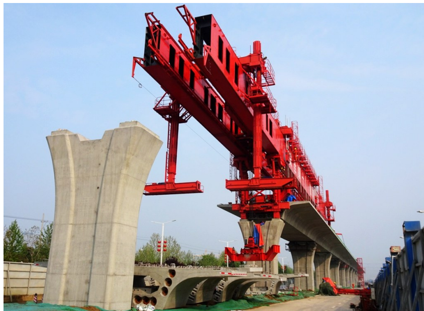
正在建设中的郑合高铁
