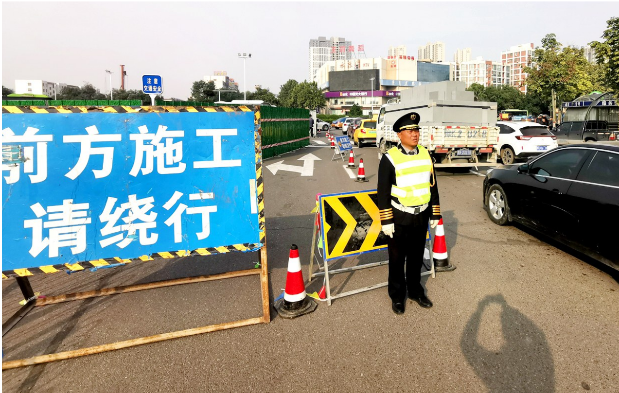
施工方专门在路口安排了交通疏导员。 记者 陈晨 摄
