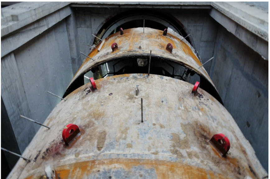
↑ 盾构机刀盘从内部挖通右线隧道,标志着郑许市域铁路许昌段隧道全线贯通。 ↓ 左线隧道盾构机接收作业井内,盾构机已经拆解。
