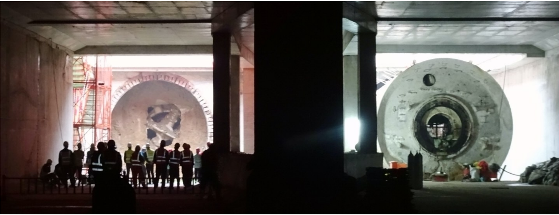
在郑许市域铁路许昌东站站房内看永许区间双线隧道。左侧为刚刚贯通的永许区间右线隧道,右侧为本月10日贯通的永许区间左线隧道。
