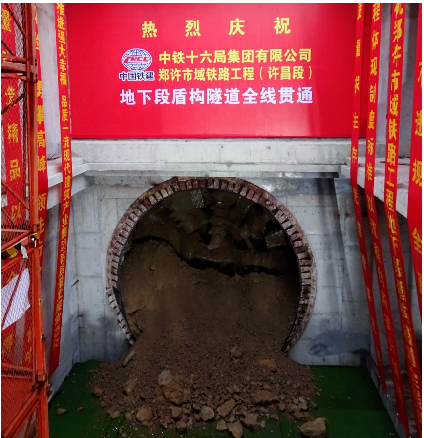
↑ 盾构机刀盘从内部挖通右线隧道,标志着郑许市域铁路许昌段隧道全线贯通。 ↓ 左线隧道盾构机接收作业井内,盾构机已经拆解。
