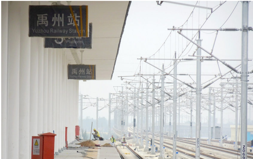
建设中的禹州站站场 资料图片由记者吕正子提供
