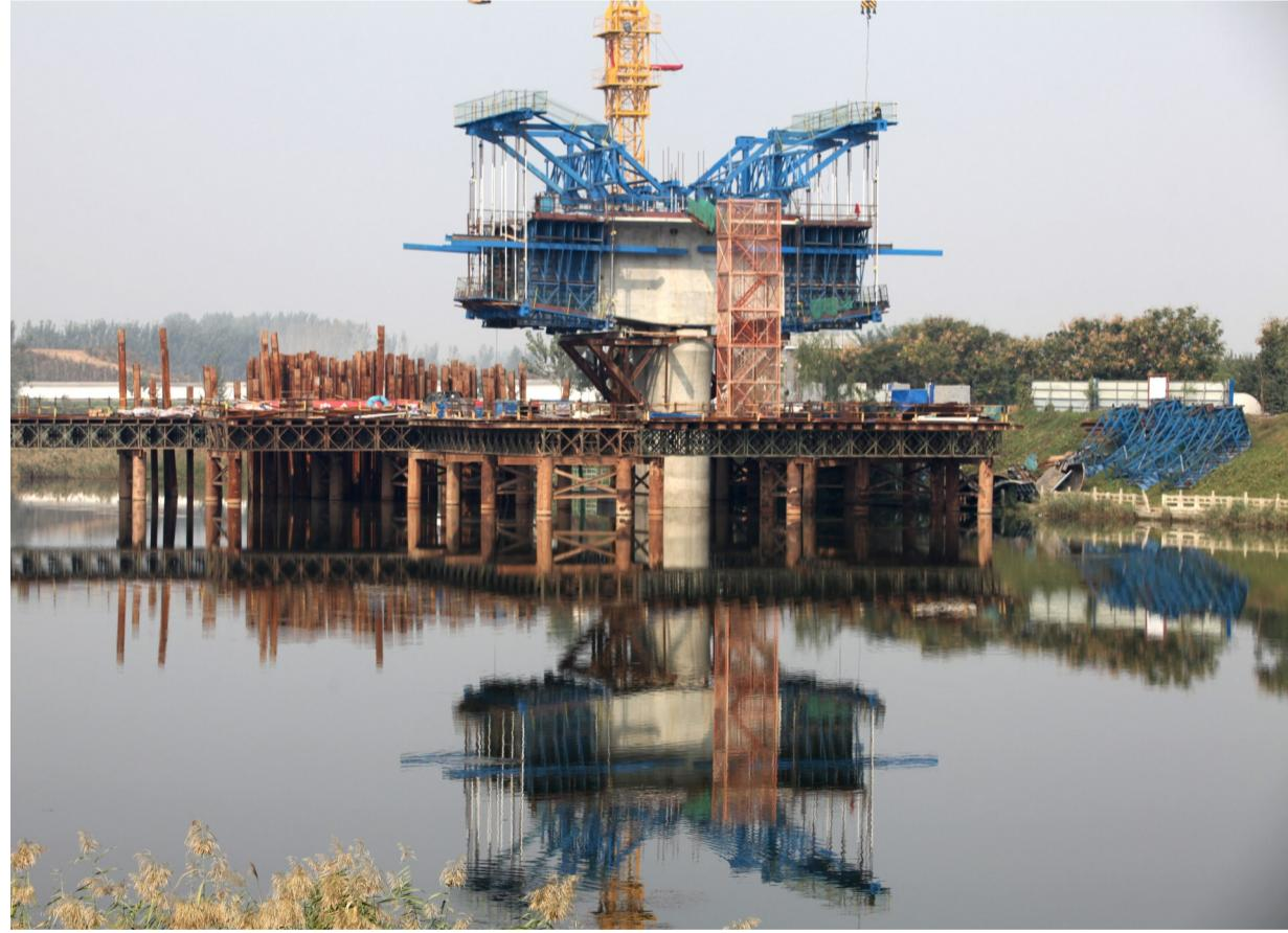
10月24日拍摄的郑许市域铁路跨双洎河桥施工现场。该项目位于长葛市双洎河湿地公园，以连续梁形式跨越双洎河，共分为24个对称浇筑段和3个合龙段，目前正在进行托架阶段施工。据悉，郑许市域铁路跨双洎河桥所在位置水面宽140米，深约6米，需水中作业的两个墩柱已完工。郑许市域铁路跨双洎河桥因地质环境复杂、施工难度大、安全风险高，为郑许市域铁路工程施工难点之一。
