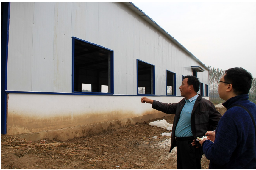
牛文现(左)向记者介绍醋厂的建设情况。图片均由许昌报业全媒体记者陈晨摄
