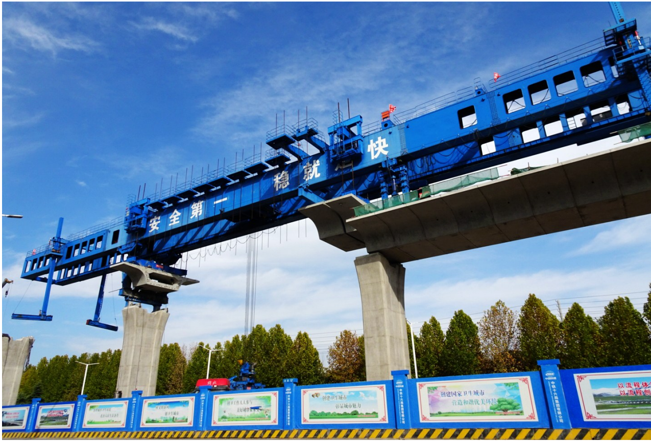
郑许市域铁路建设工地，架桥机正在架梁。 记者 吕正子 摄
