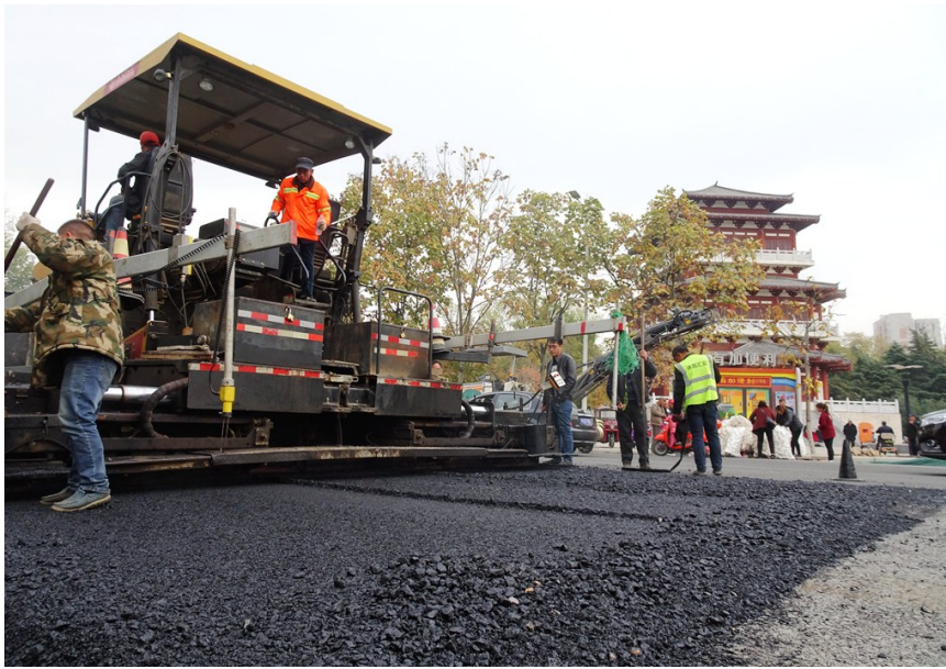
摊铺机在摊铺沥青。
