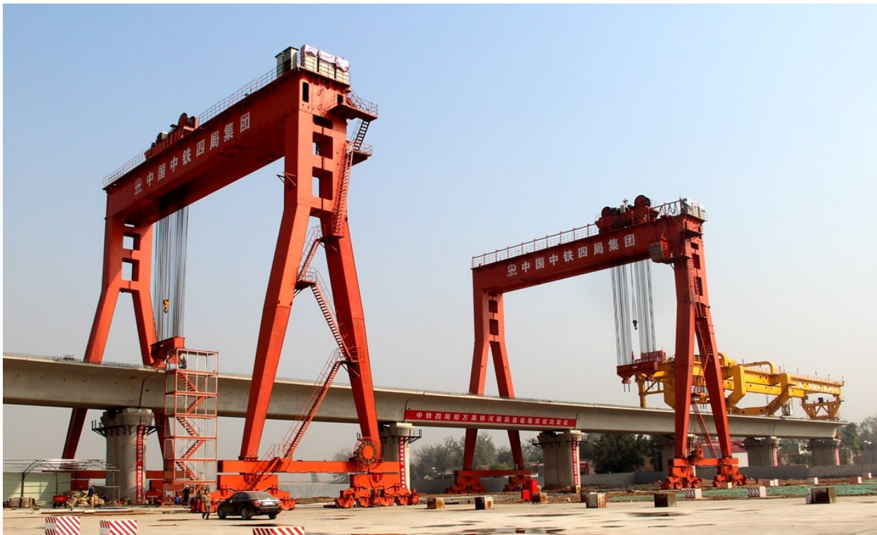
2016年10月17日,中铁四局集团长葛东制梁场旁架设好的箱梁。
