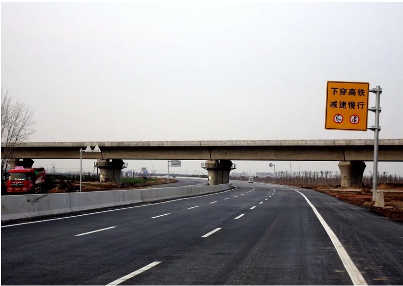
郑阜高铁上跨新107国道,一条高铁、一条干线公路共同给力郑许一体化。
