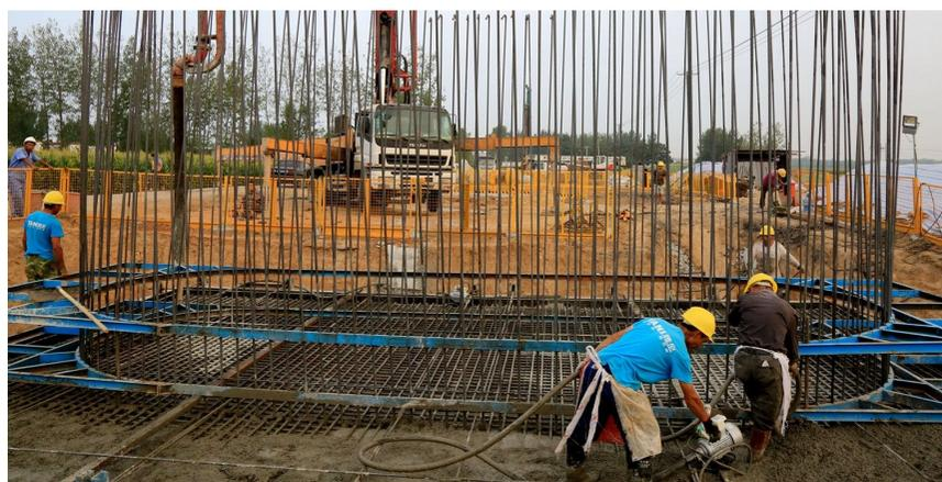
2016年8月7日,建筑工人在浇筑郑渝高铁禹州段境内的一个桩基。
