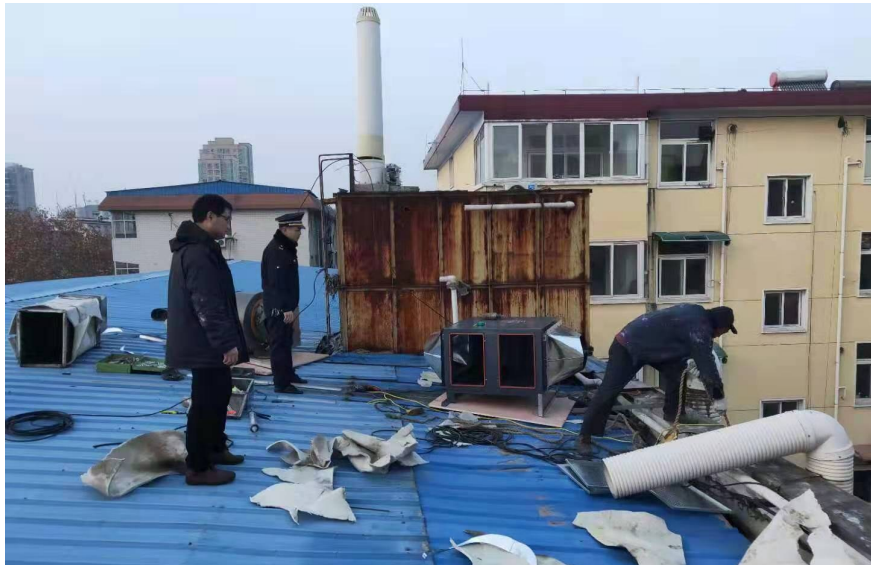
工人安装油烟净化器,执法人员现场监督。资料图片
