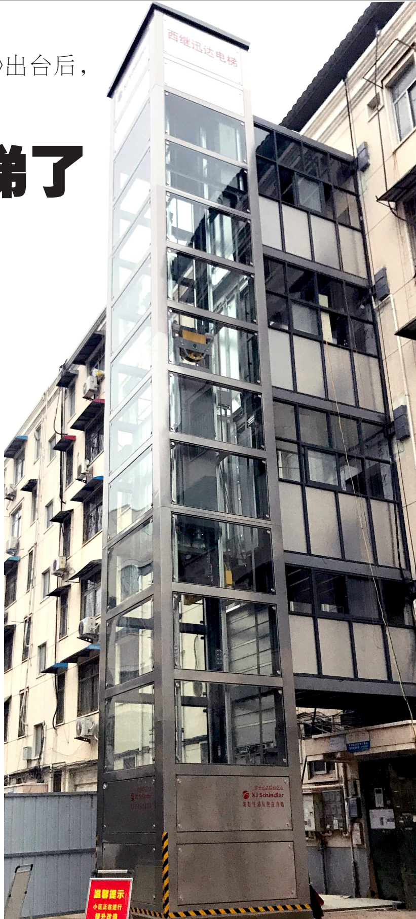
青竹苑小区17号楼3单元加装电梯完工。记者 代玺 摄
