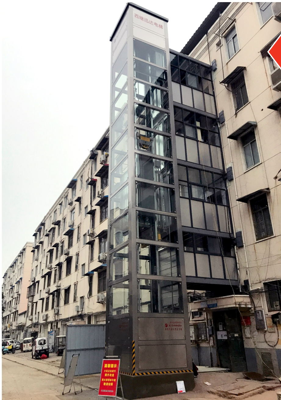
市区望田路青竹苑小区17号楼3单元加装电梯完工。记者 代玺 摄
