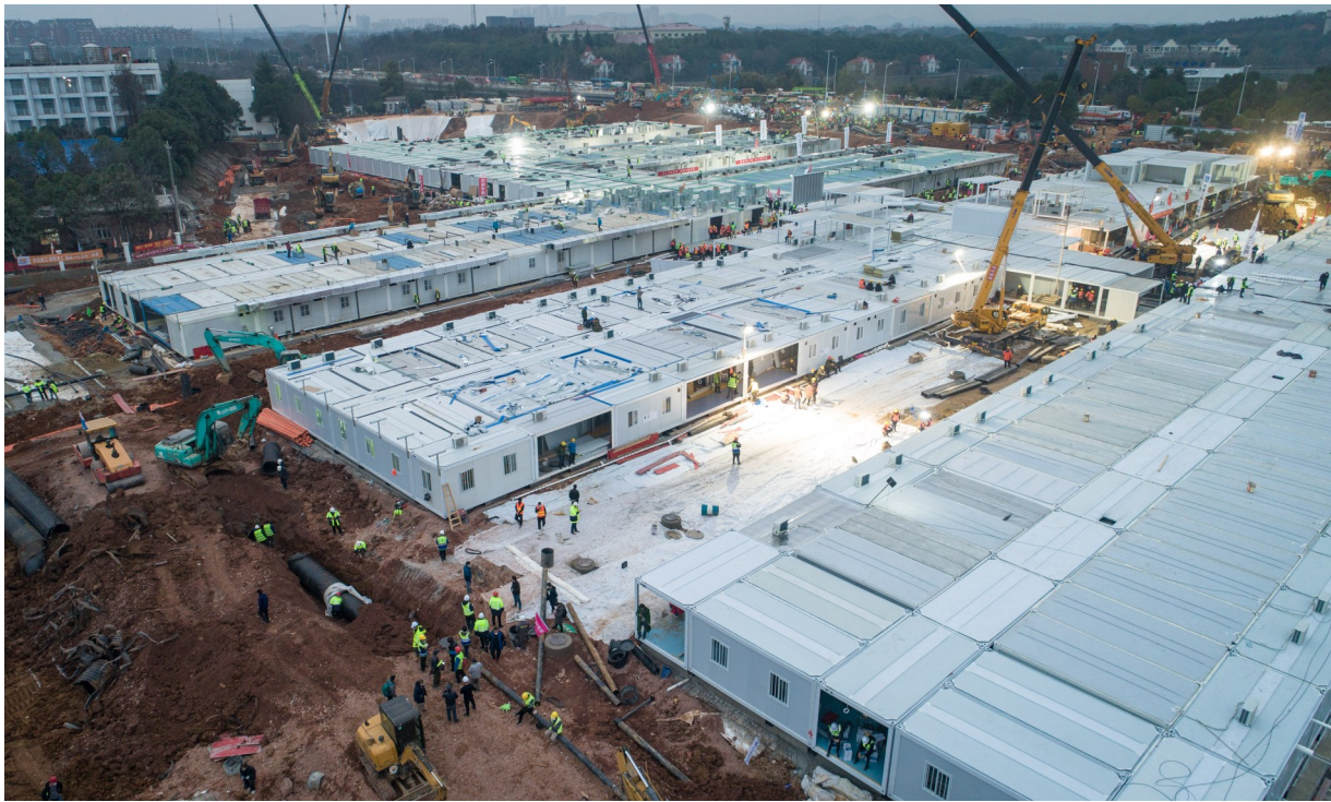
2月1日拍摄的武汉火神山医院建设工地(无人机照片)。新华社发
