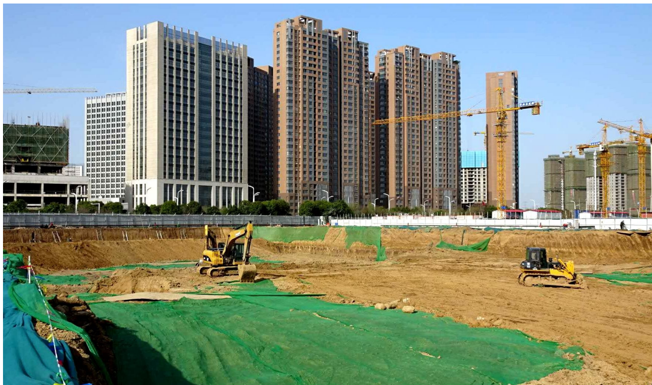
正在施工的德仕堡生活广场项目的基坑 记者 吕正子 摄
