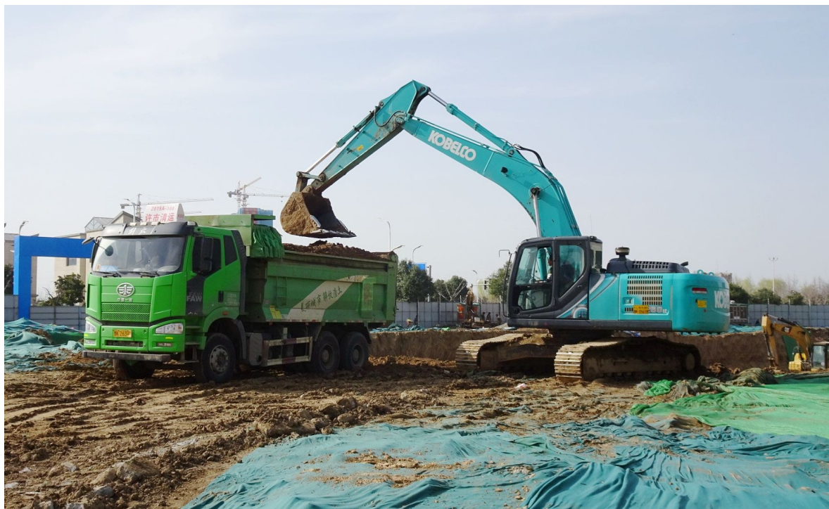
挖掘机在进行土方挖掘作业。记者 吕正子 摄
