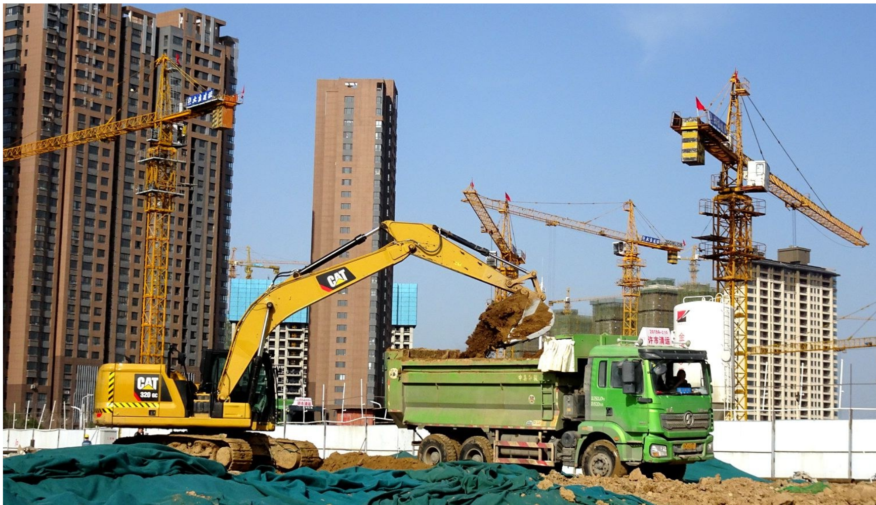
挖掘机正在进行土方挖掘作业。记者 吕正子 摄
