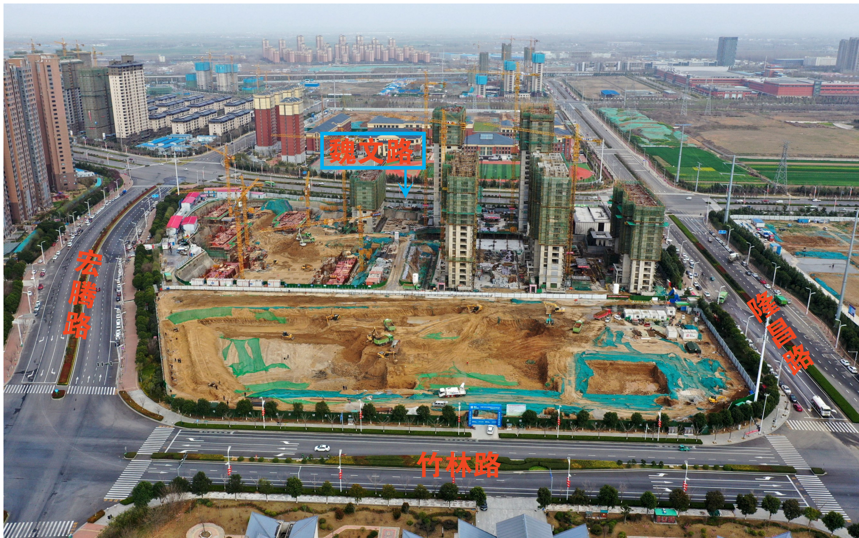
3月11日航拍的建设中的德仕堡生活广场 记者 牛书培 摄
