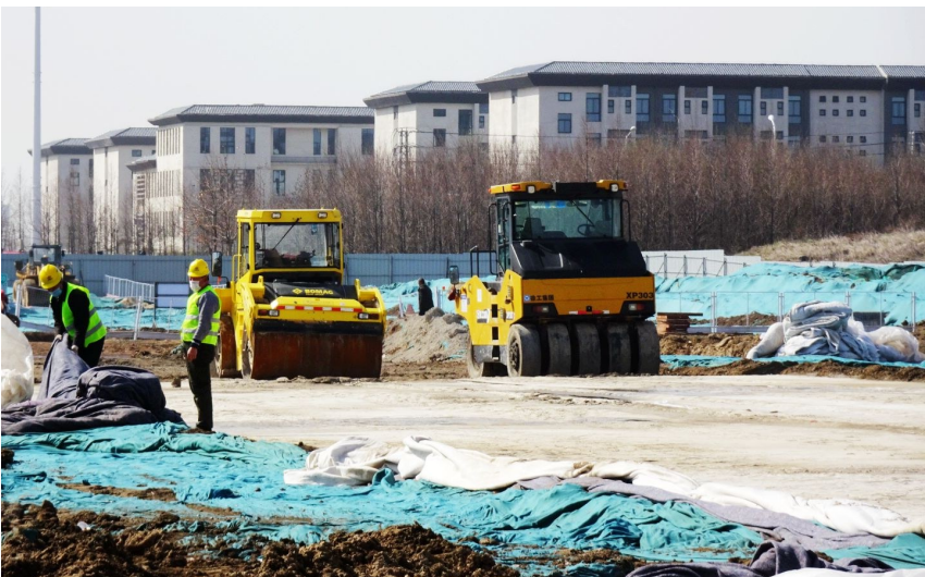
正在施工的忠武路 记者 吕正子 摄
