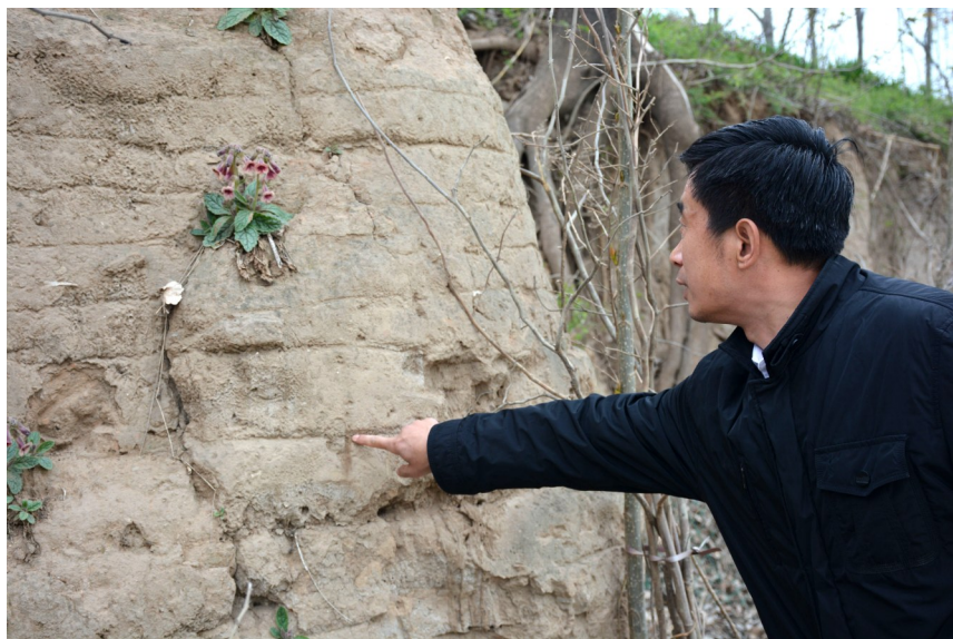
鄢陵县文管所副所长苏志伟介绍城墙夯筑情况。
