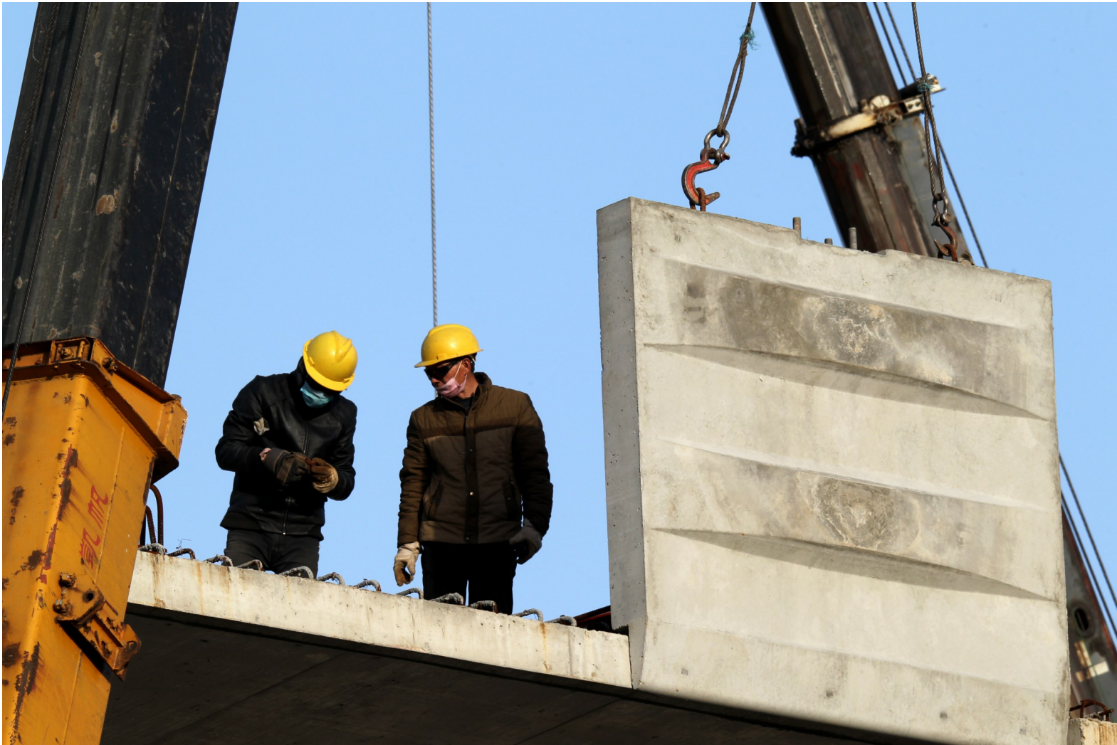
郑许市域铁路加紧“北进” 4月7日,中铁十六局集团郑许市域铁路施工现场,工人正在进行安装护墙作业。目前,郑许市域铁路桥梁铺设、节段梁架设和现浇梁浇筑等工作正在有序进行。 记者 牛书培 摄 【详见4版】
