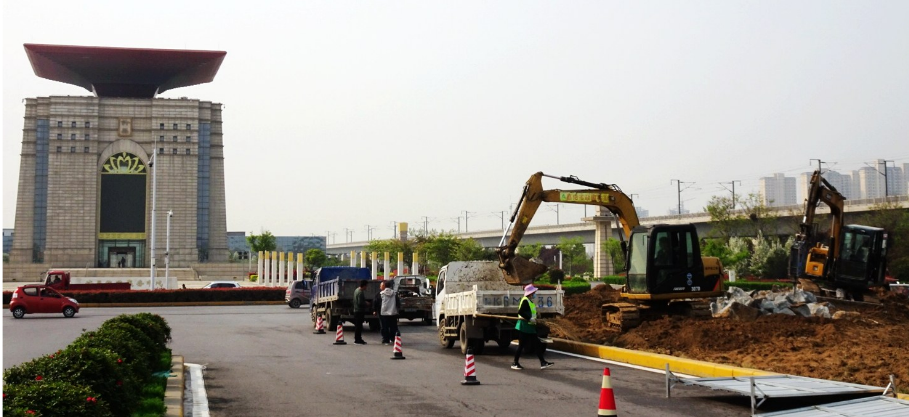
施工中的许昌高速口对面交通岛 记者 吕正子 摄
