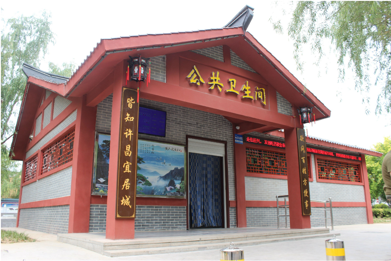
东顺河街与建安大道交会处附近的“智慧公厕” 记者 张铮 摄
