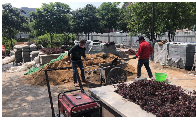
蝴蝶广场施工现场 记者张铮摄
