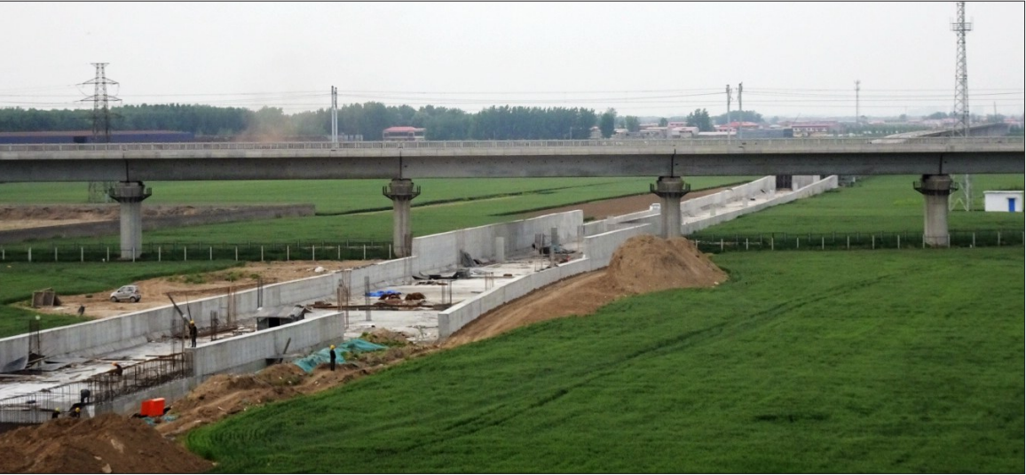
郑许市域铁路下穿郑万高铁处。记者 吕正子 摄
