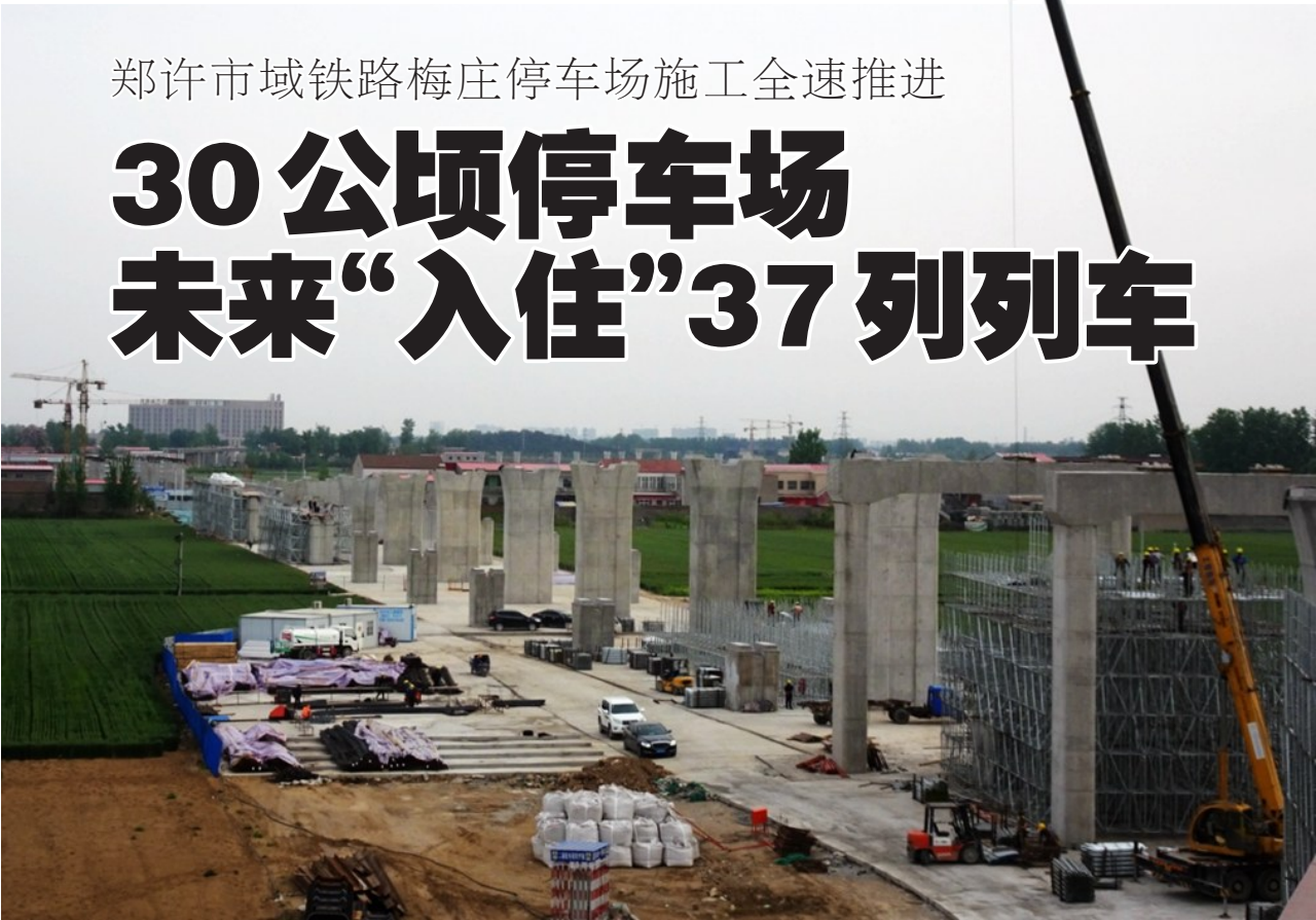
梅庄停车场列车出入线与郑许市域铁路正线、高桥墩为出入线桥墩。记者 吕正子 摄
