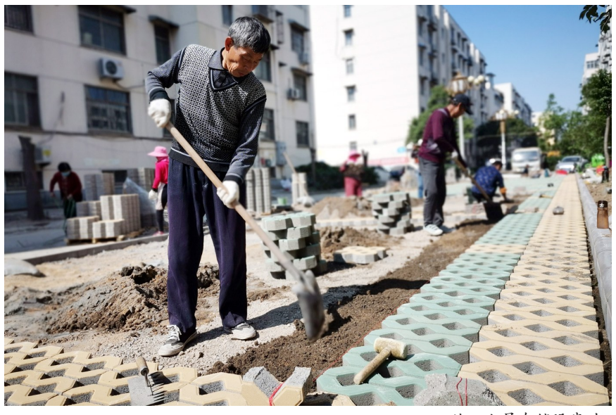
施工人员在铺设步砖。
