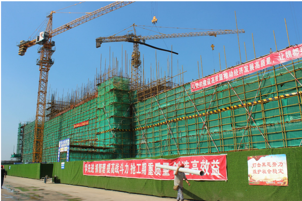
建设中的许昌旺能环保能源有限公司 资料图片
