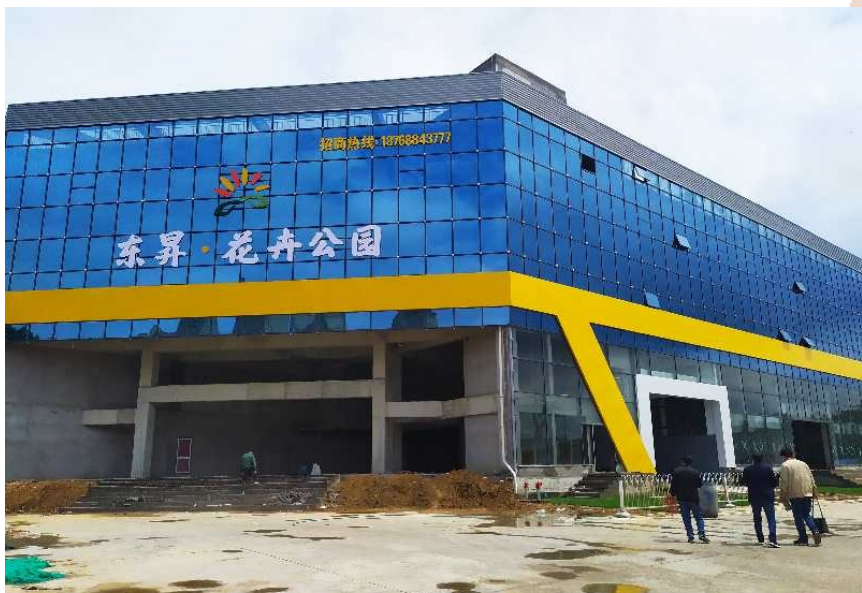
位于许州北路与新东街东北角的东昇·花卉公园主体建筑已经完工。记者 张辉 摄
